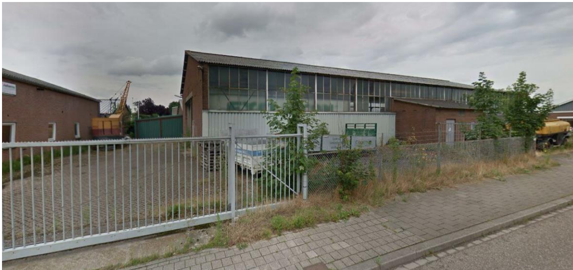
Beeld van het plangebied vanaf De Ruijterstraat, met loods
